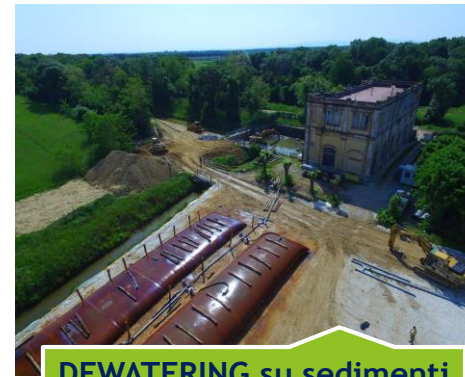
DEWATERING su sedimenti da dragaggio Imp. Idrovoro Coltano - PI Consorzio 4 B. V.
